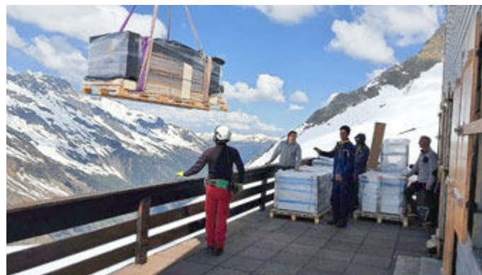
Materialanlieferung per Hubschrauber. Übrigens, auch ein neues Gipfelkreuz für den Schwarzkopf wurde mit auf die Hütte geflogen; Bild: Gunter Ungerecht
